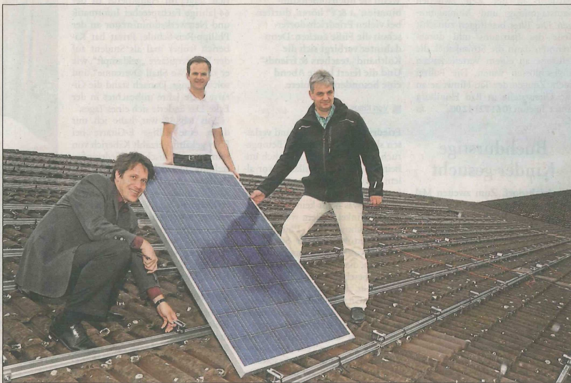
Erster Stadtrat Jürgern Odszuck, Patrick Schramm von Taunus Solar-Energie und Uwe Müller, Geschäftsführer der Kronberger Stadtwerke, (v.l.) montieren das erste Modul der Bürgersolaranlage auf ein Dach des Betriebshofs. Fotos: Jochen Reichwein
